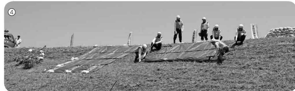
①防災航空隊ヘリによる救出救助 ②水防団出動 ③五徳縫い ④表シート張り
