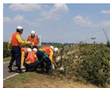
▲水防工法（木流し）
