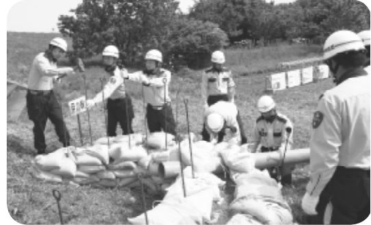
③月の輪工法：堤防面に対し、半円形に土のうを積み上げ、漏水部分の水圧を減衰させて、堤防の決壊を防ぎます。
