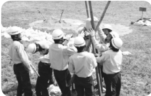
②五徳縫い工法：竹とげした竹3、4本を地中深く差し込み、結束後、土のうをくくりつけ、堤防面の亀裂拡大を防ぎます。
