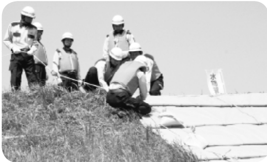
①表シート張り工法：防水シートを使って、堤防への浸水や堤防表面の侵食を防ぎます。
