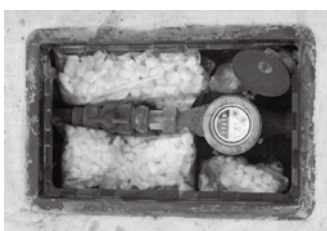
発泡スチロールを小さく切って使用した凍結対策の例
