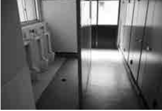
改修予定の三保谷小学校のトイレ
