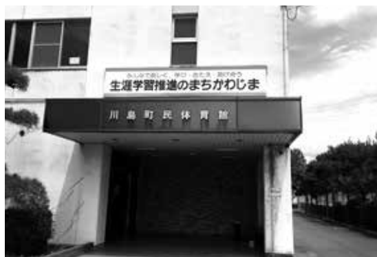
改修予定の川島町民体育館
