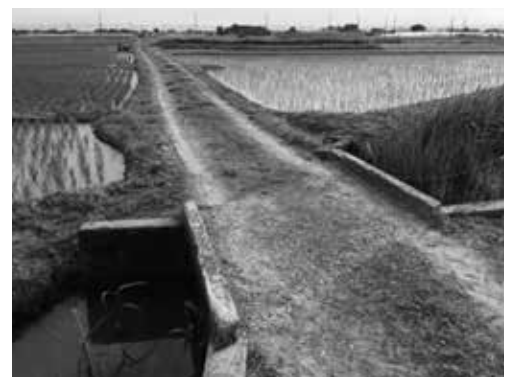
大型農業機械が通行できない橋
