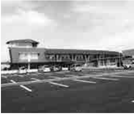
業務核ゾーン中心の新庁舎
