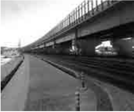
日中も日陰の圏央道北側側道の歩道
