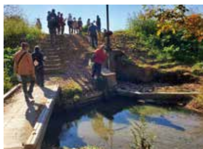
▲正直地区内の山王樋管を見学 樋管＝堤防を横断する水路のこと
