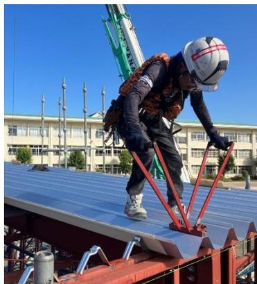
写真左は、鉄骨の屋根面に屋根材を載せるための下地（タイトフレーム）を取り付けた状況です。
