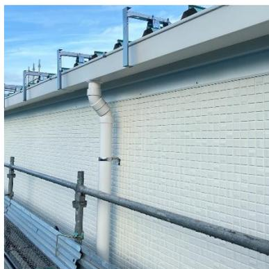
外壁材は、窯業系サイディングという、セメントと木材繊維などを薄い板に加工した材料を使います。
