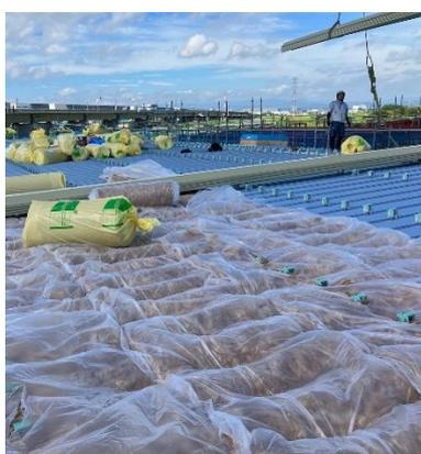
この屋根は、高断熱性能の仕様で、折板に断熱材（グラスウール）を挟み込む工法（ダブルパック工法）を採用します。
