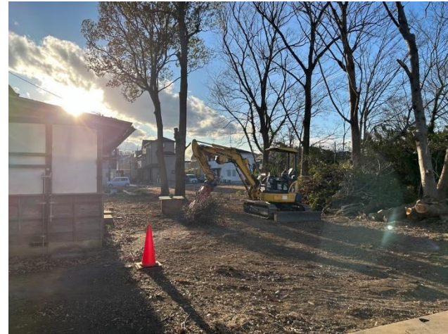
北側樹木伐採・処分後
