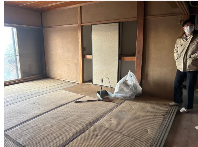
居室 2 撤去・処分後
