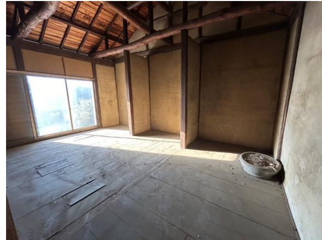
納戸撤去・処分後
