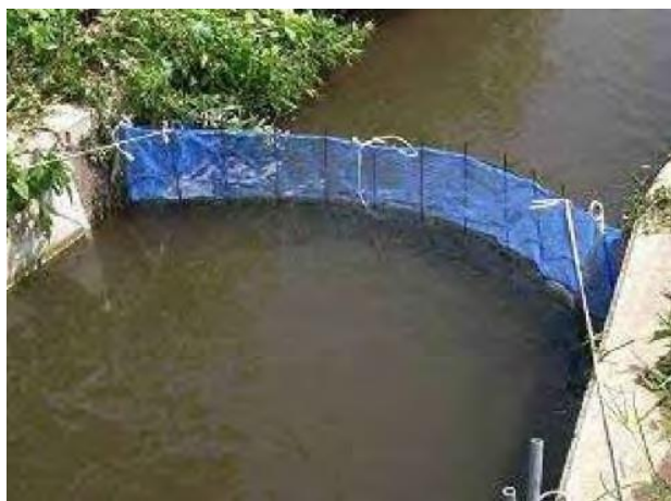
流出防止を目的とした網の設置例
