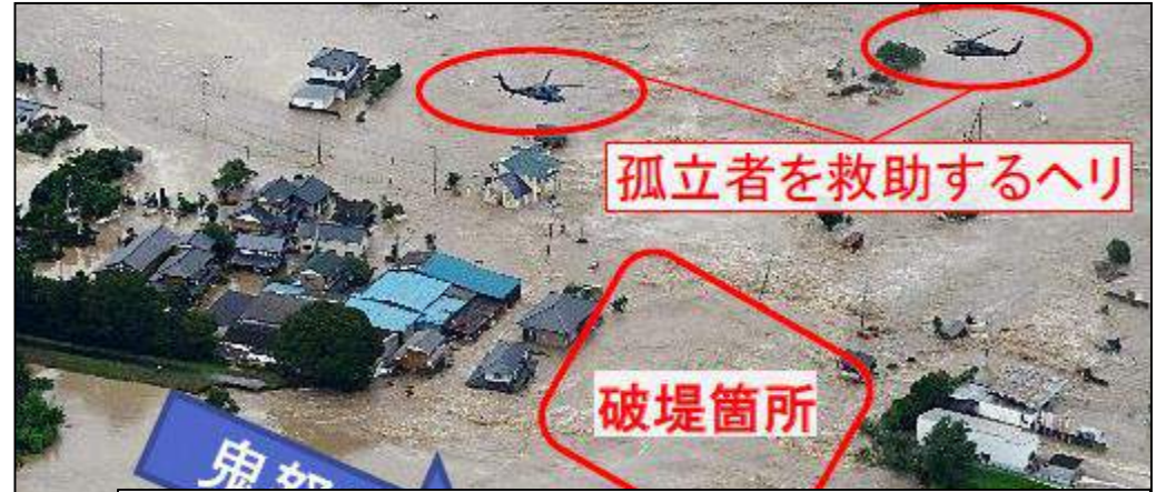
茨城県常総市 鬼怒川破堤 (H27年9月関東・東北豪雨)
