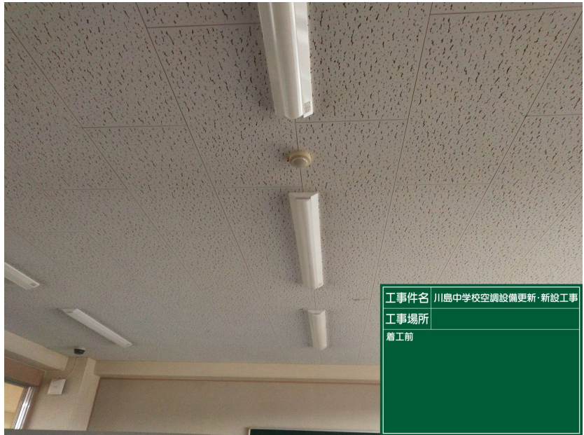
【工事件名】川島中学校空調設備更新・新設工事 【】着工前
