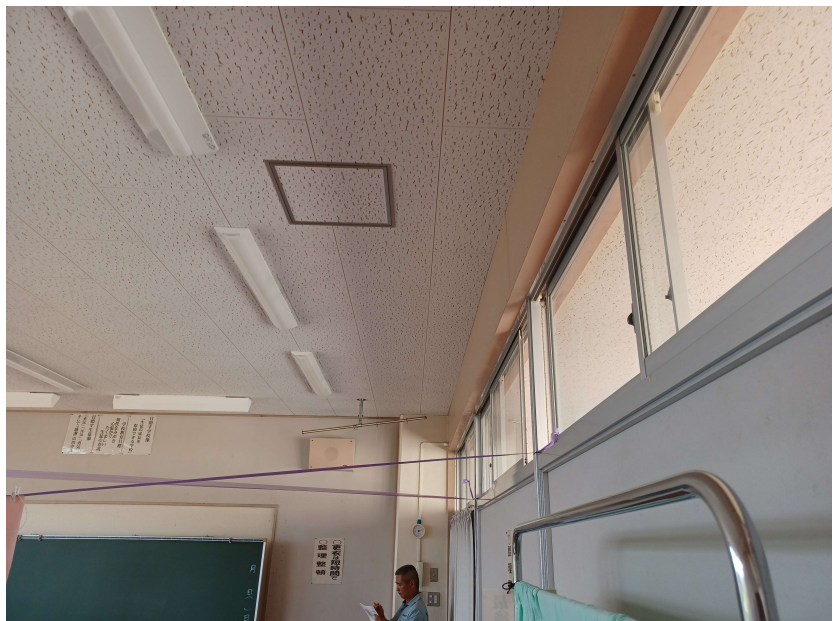
【工事件名】川島中学校空調設備更新・新設工事 【】施工前
