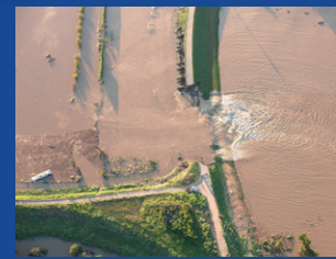
2019年10月14日 台風第19号における越辺川の状態 (写真提供：国土交通省 荒川上流河川事務所)
