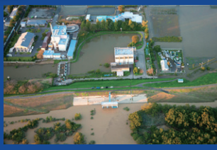
2019年10月14日 台風第19号における入間川（川島排水機場）の状態 (写真提供：国土交通省 荒川上流河川事務所)
