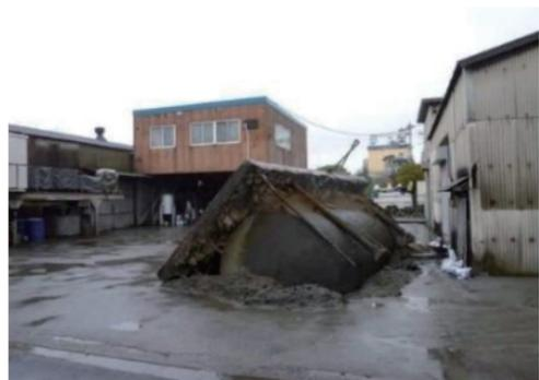
液状化による段差(写真左)と、地下タンクの浮き上がり(写真右) 出典：「実態調査から見える被害状況」(NPO法人シビルまちづくりステーション)
