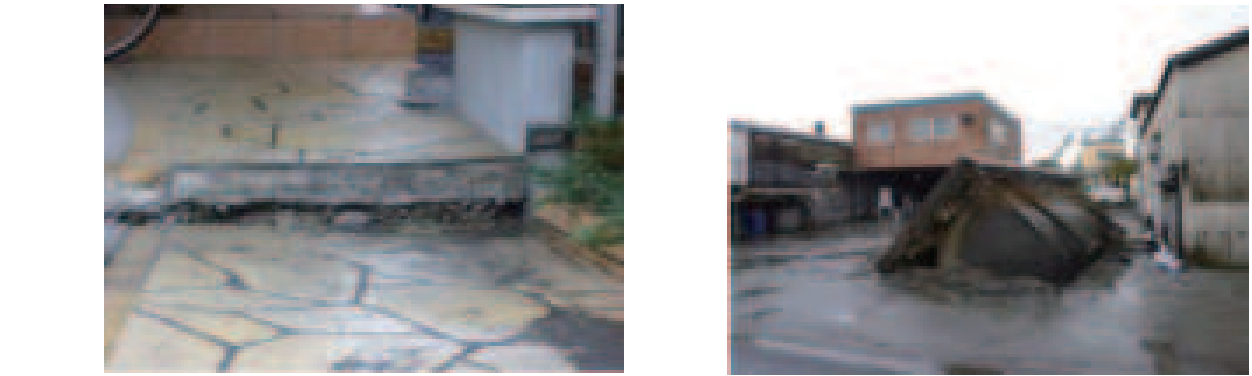
液状化による段差 (写真左) と、地下タンクの浮き上がり (写真右) 出典：「実態調査から見える被害状況」(NPO法人シビルまちづくりステーション)
