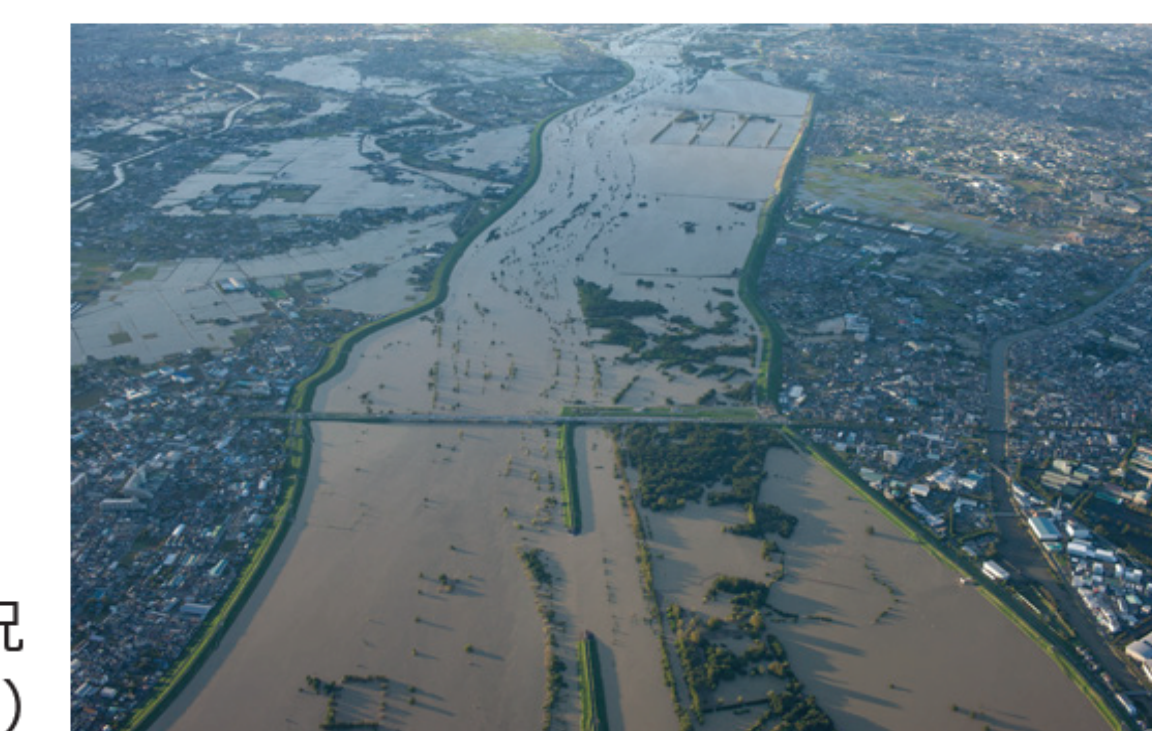
2019年10月14日 台風第19号における荒川の状況 (写真提供：国土交通省 荒川上流河川事務所)
