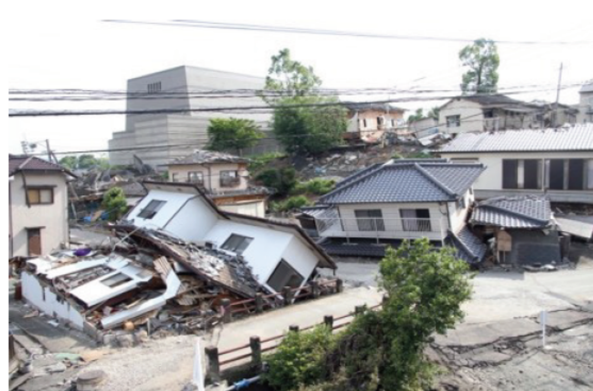
2016年4月 熊本地震による益城町寺迫地区の被災状況 (写真提供：熊本県益城町役場)
