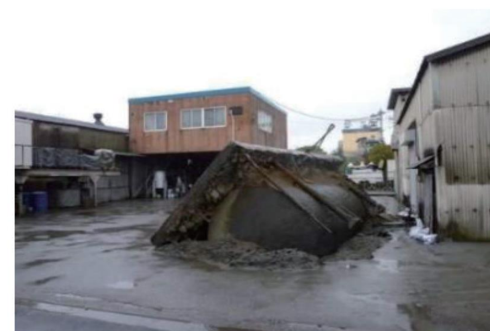
液状化による段差(写真左)と、地下タンクの浮き上がり(写真右) 出典：「実態調査から見える被害状況」(NPO法人シビルまちづくりステーション)
