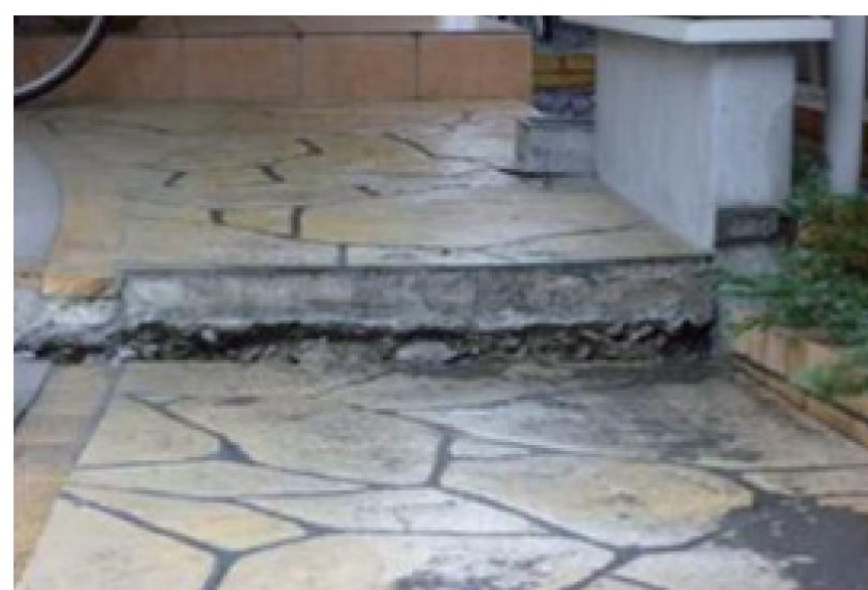
液状化による段差(写真左)と、地下タンクの浮き上がり(写真右) 出典：「実態調査から見える被害状況」(NPO法人シビルまちづくりステーション)
