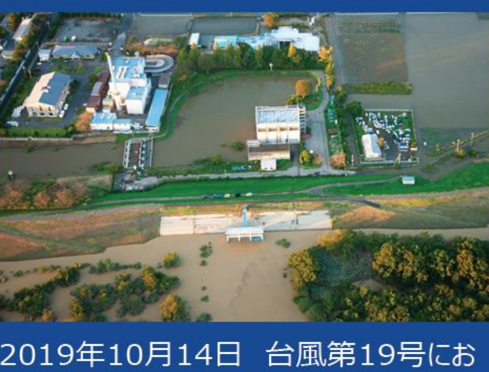
2019年10月14日 台風第19号における入間川 (川島排水機場) の状況 (写真提供：国土交通省 荒川上流河川事務所)
