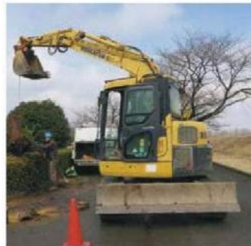
(写真23) 伐根作業
