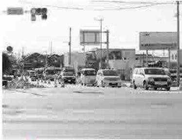
▲ 3月1日時点の工事状況
