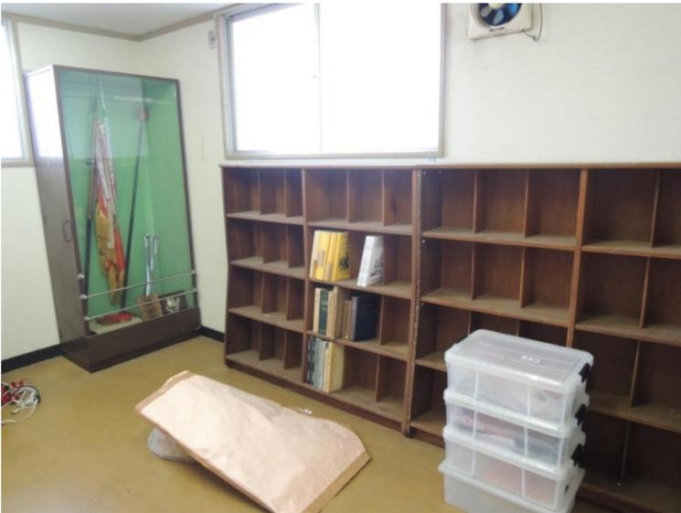
○棚の固定…… 棚の上部を、L字金具により壁に固定
