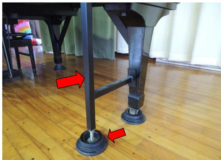
ピアノ耐震化②……斜め支持材により脚部補強
