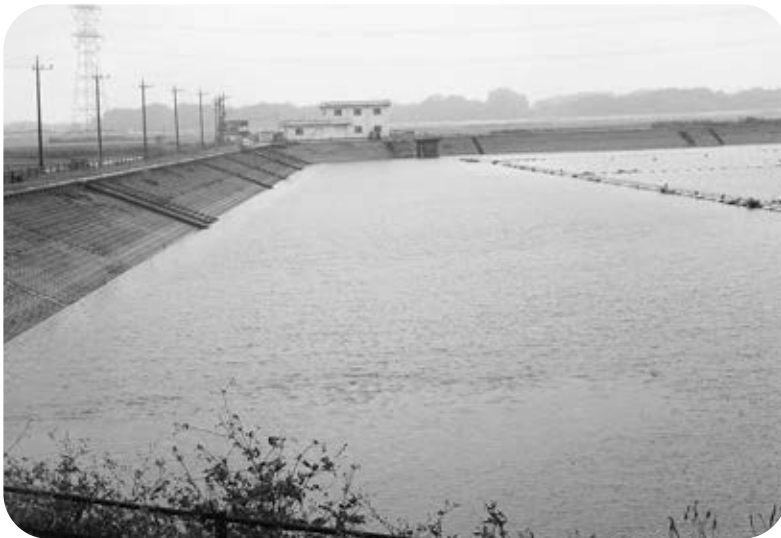
土地改良区梅ノ木古凍貯水池
