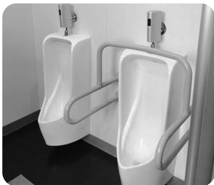
きれいに生まれ変わったトイレ（中山小学校）
