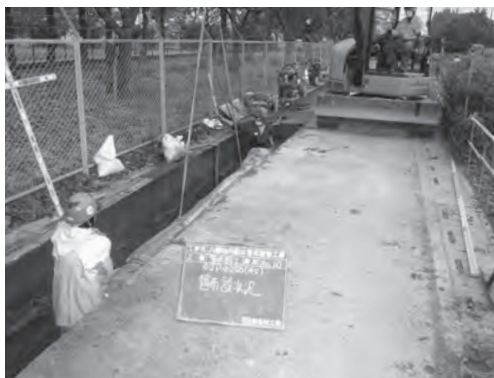
水道管の敷設工事
