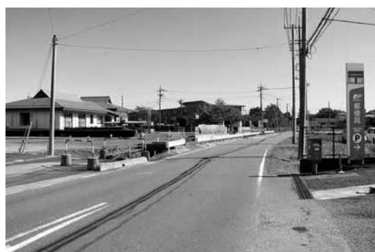
町道1-23号線を整備
