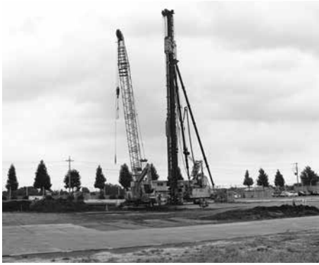
杭打工事開始
