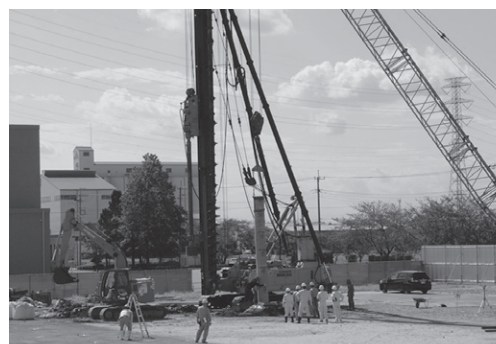
新庁舎の杭打ち工事
