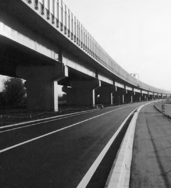
新設された圏央道側道
