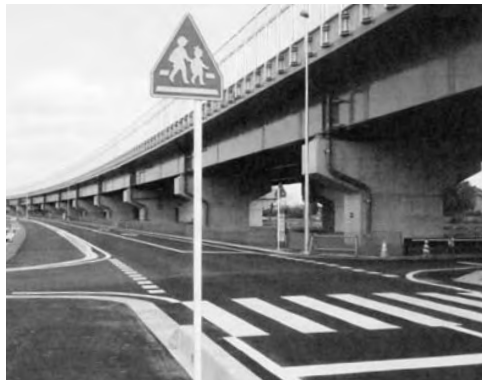
祈る交通安全側道（川中前）
