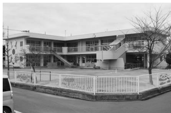
外壁工事が終了した「けやき保育園」
