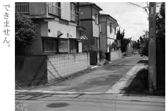
市街化区域内の未舗装の道路
