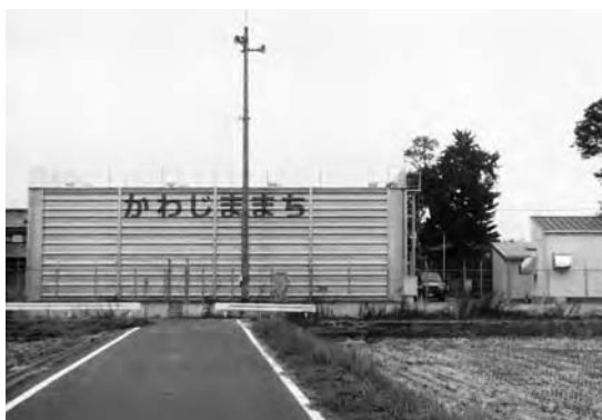
県水を受水している平沼浄水場
