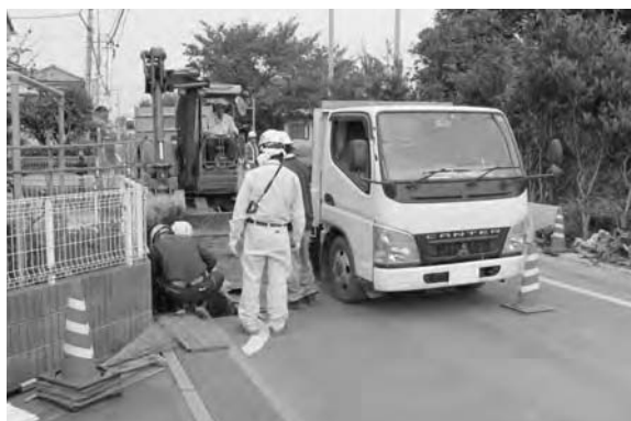
町道改良工事
