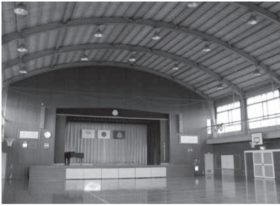
耐震化を図る小学校体育館
