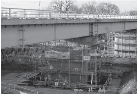
耐震工事中の市野川大橋
