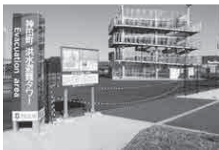
日立市洪水避難タワー
