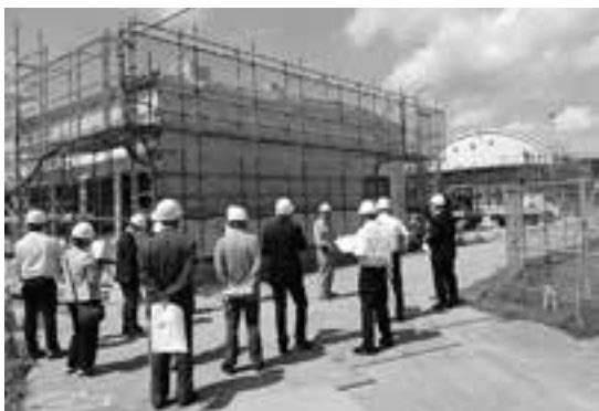
施工業社から、工事の概要説明を聞く
