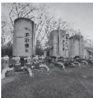
改修が望まれる水道施設
