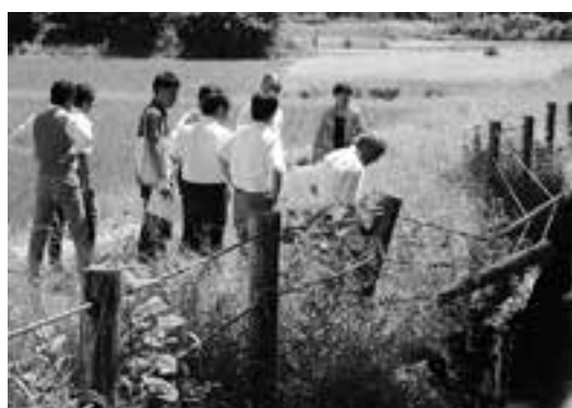
横塚川（出丸中郷地内）の損傷箇所を確認する
