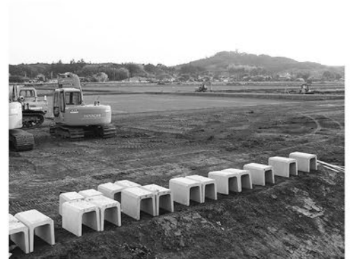
農地中間管理機構による大規模区画化工事 (滑川町)
