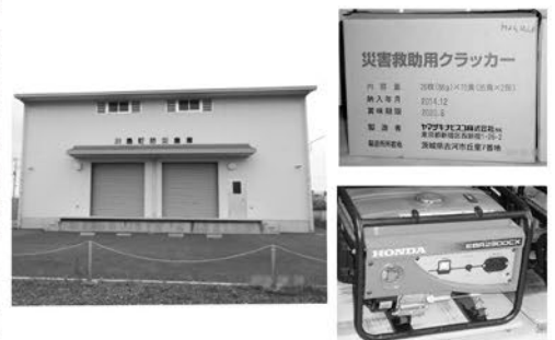
川島町防災倉庫
