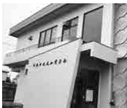
川島町水道企業庁舎
