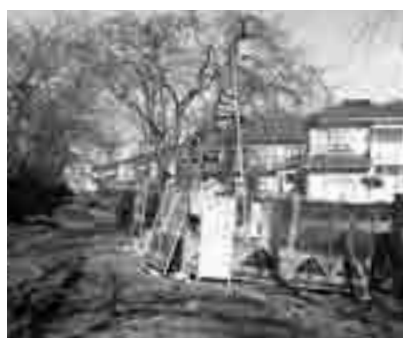
噴砂現場のボーリング調査
