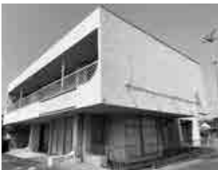
老朽化した公共施設の機能統合を （出丸公民館・昭和48年建設）
