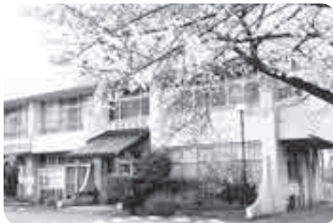
解体を予定している中山公民館
