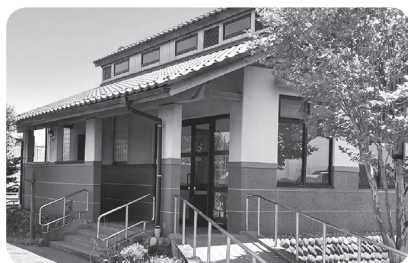
改修されるいこいの広場トイレ
