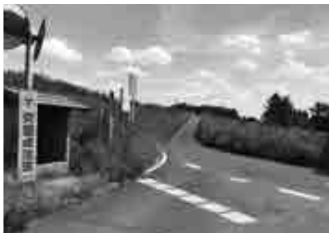
草木が繁茂して走行しづらい道（樋結周辺）
