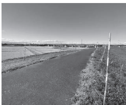
▲町ハザードマップ想定破堤点(54・4キロ付近)の天端の状況
