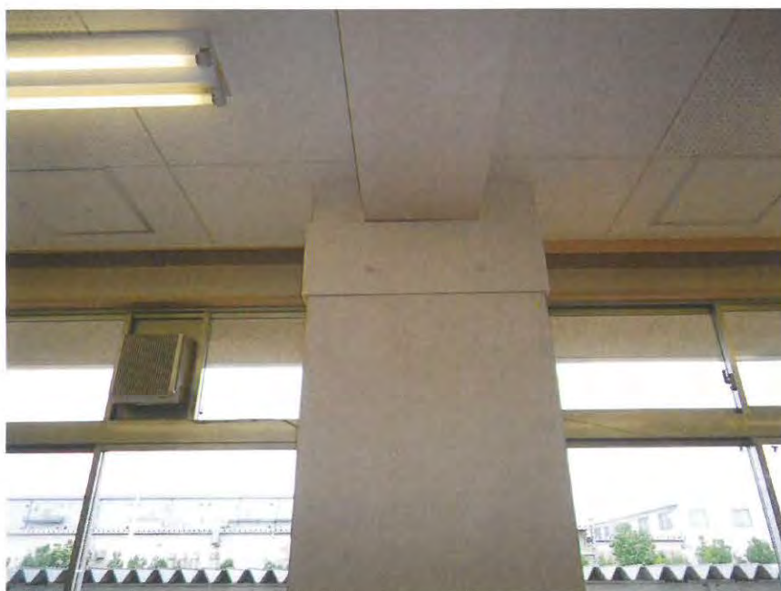
工事完了 [金工室]
