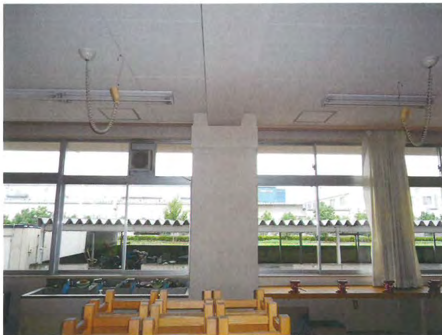
工事完了 [金工室]
