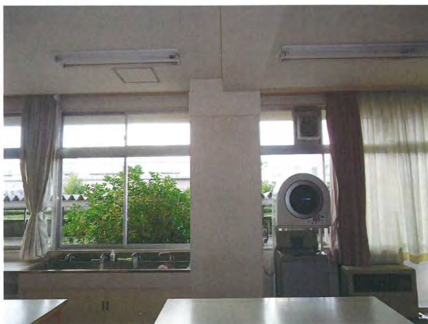
工事完了 [被服室]
