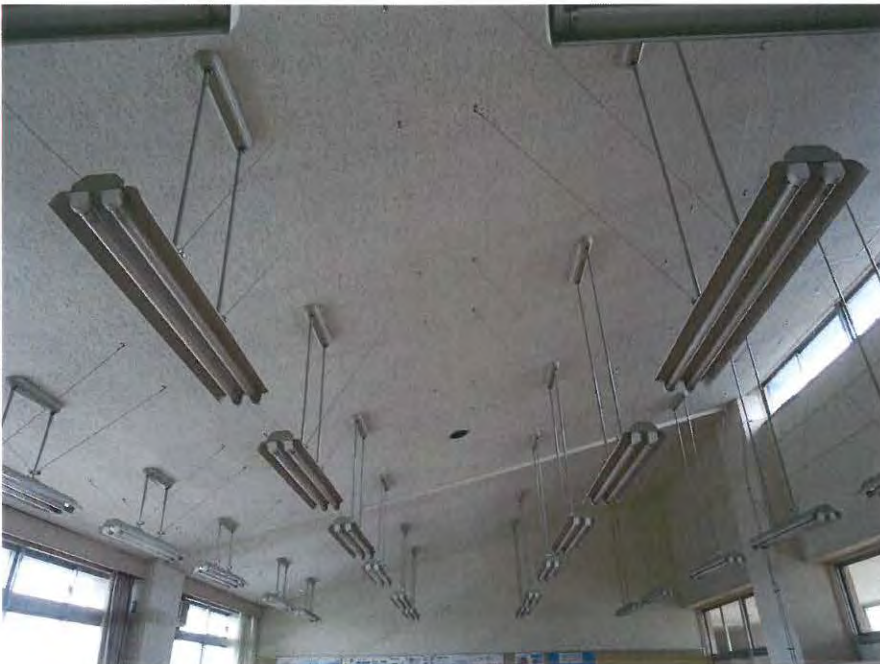
仕上ユニット工事 吊照明取付補強 補強金具取付状況 [美術室]
