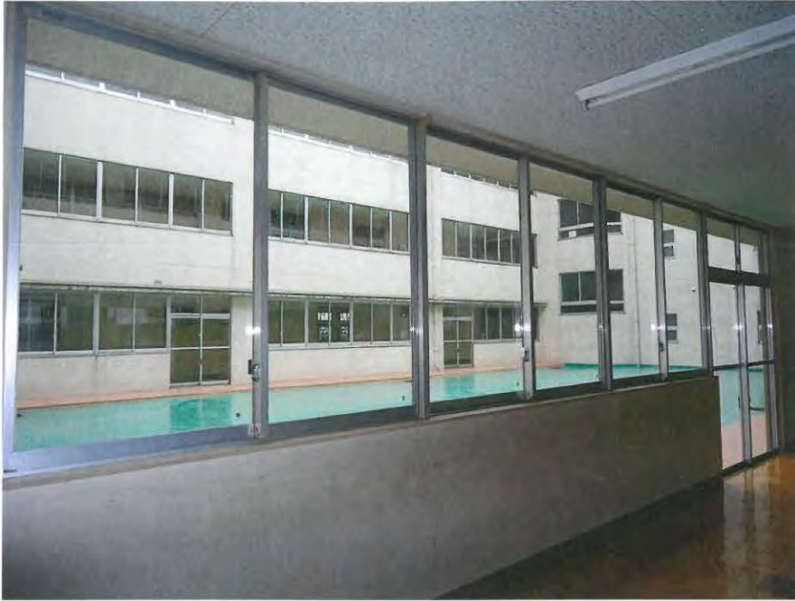
ガラス改修工事 ガラス交換状況 [廊下]
