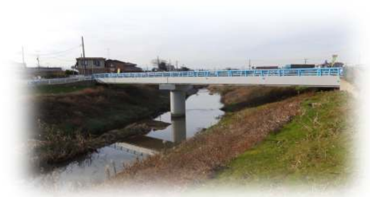
町道 5235 号線 : 5-56 号橋（平成 28 年度補修工事済み）
