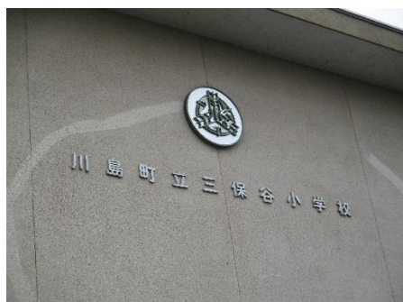
【a.外壁のサイン（三保谷小学校）】
