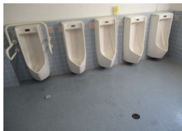
男子トイレ(内部)
