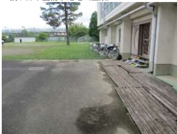
▲渡り廊下整備予定地（全景）
