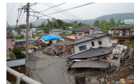
【熊本地震による被害状況】
