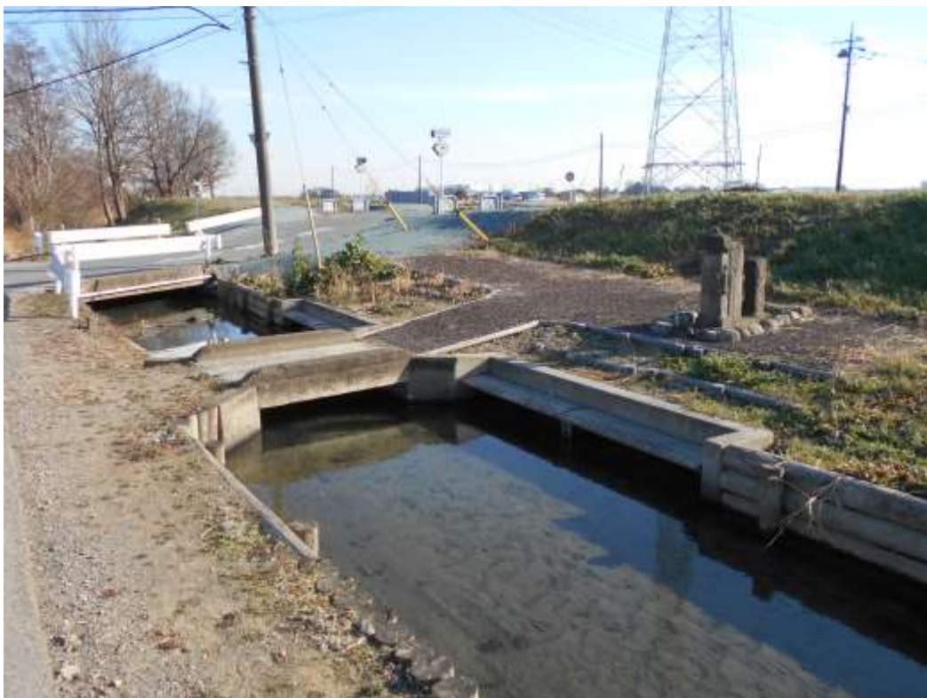
～かわのまるごと再生プロジェクト～ 歴史的建造物である六地藏を保全するとともに サイクリングや散歩の休憩所として、ポケットパークを設置 (長楽用水路)
