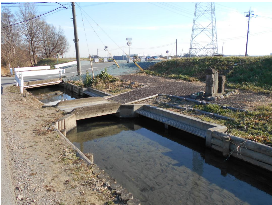
～かわのまるごと再生プロジェクト～ 歴史的建造物である六地藏を保全するとともに サイクリングや散歩の休憩所として、ポケットパークを設置 (長楽用水路)
