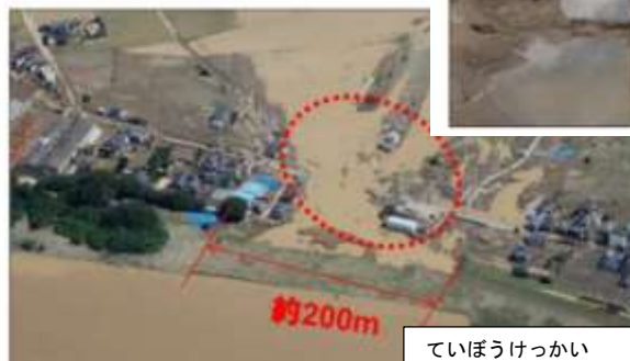
堤防決壊による家屋の流出
